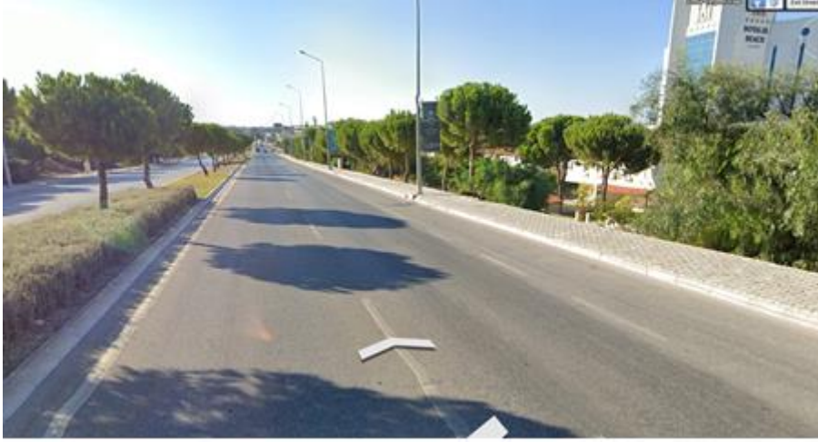
Şekil 3.21 D300-01 devlet karayolu F kesimi görüntüsü.
