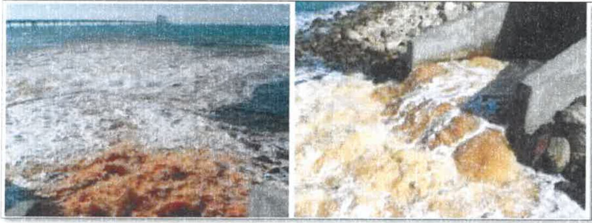
Şekil 4: Ashkelon SWRO tesisinden ön arıtmadan kaynaklı Fe+3 renkliliği
