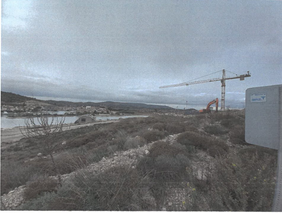
Fotoğraf 33: Alaçatı Körfezinde halihazırda sürdürülen inşaat çalışmaları.
