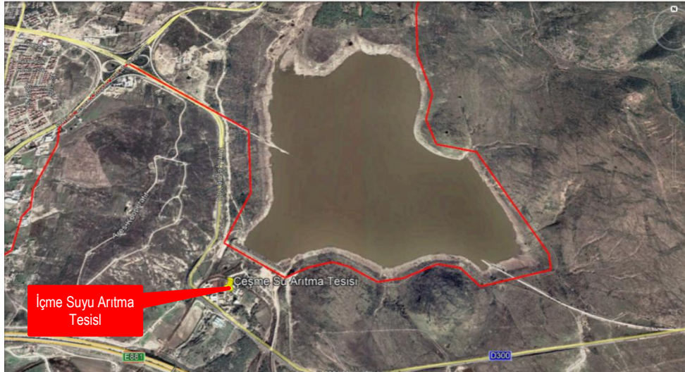
Şekil 52: Çeşme İçmesuyu Arıtma Tesis
